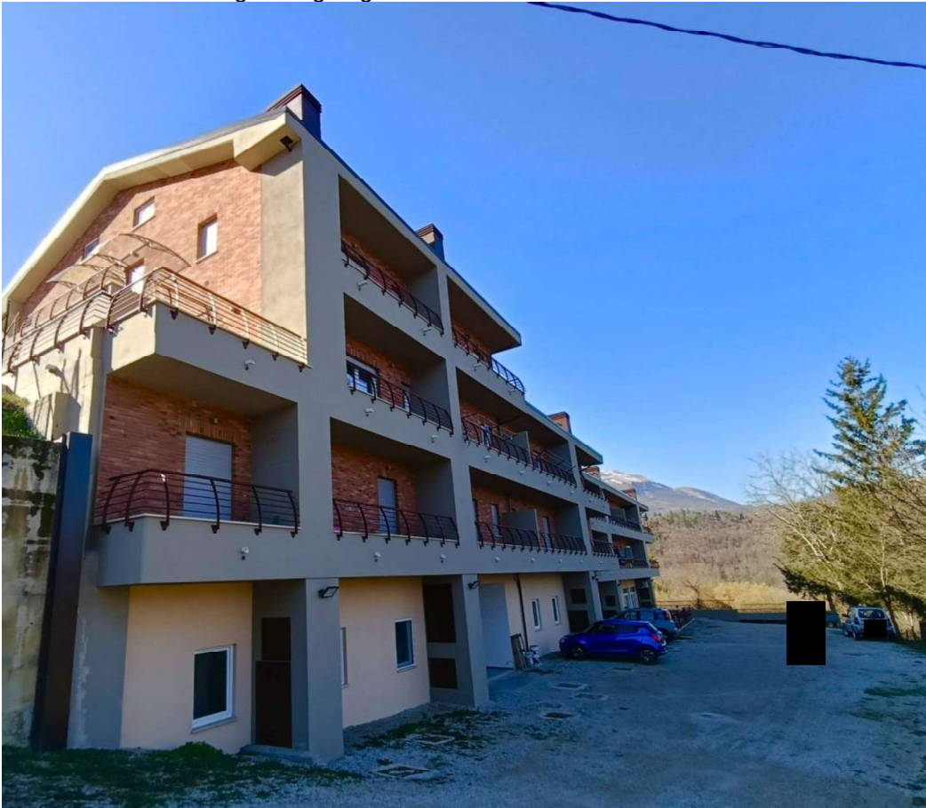
Vista cortile interno ingresso garage
