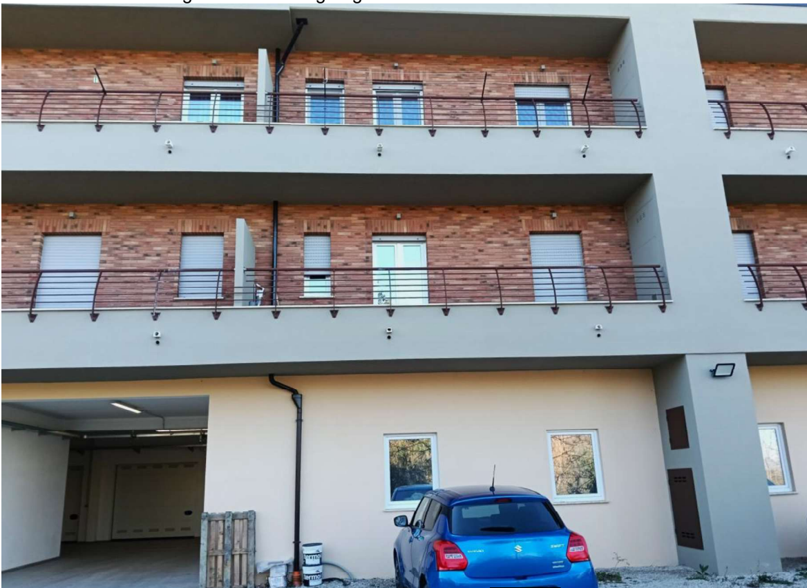
Vista cortile interno ingresso androne garage
